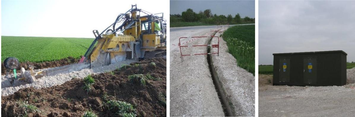
Illustration d'une trancheuse en action, d'une tranchée et d'un poste de livraison (Source: Total Quadran).
